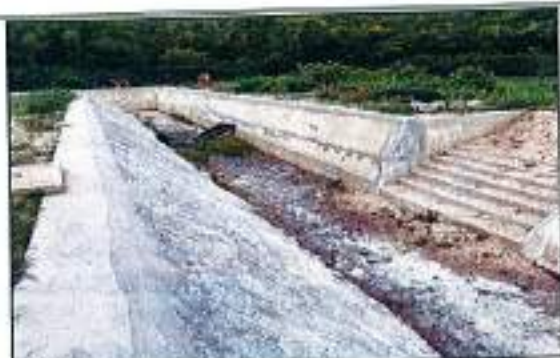
Mương thoát nước mưa xung quanh
